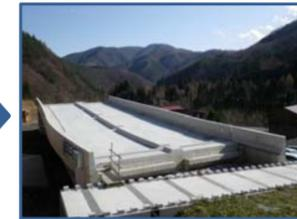
下片巢橋上部工はプレストレストコンクリート桁・長さ32.4mが4本で構成され、11月22日に完成しました。
